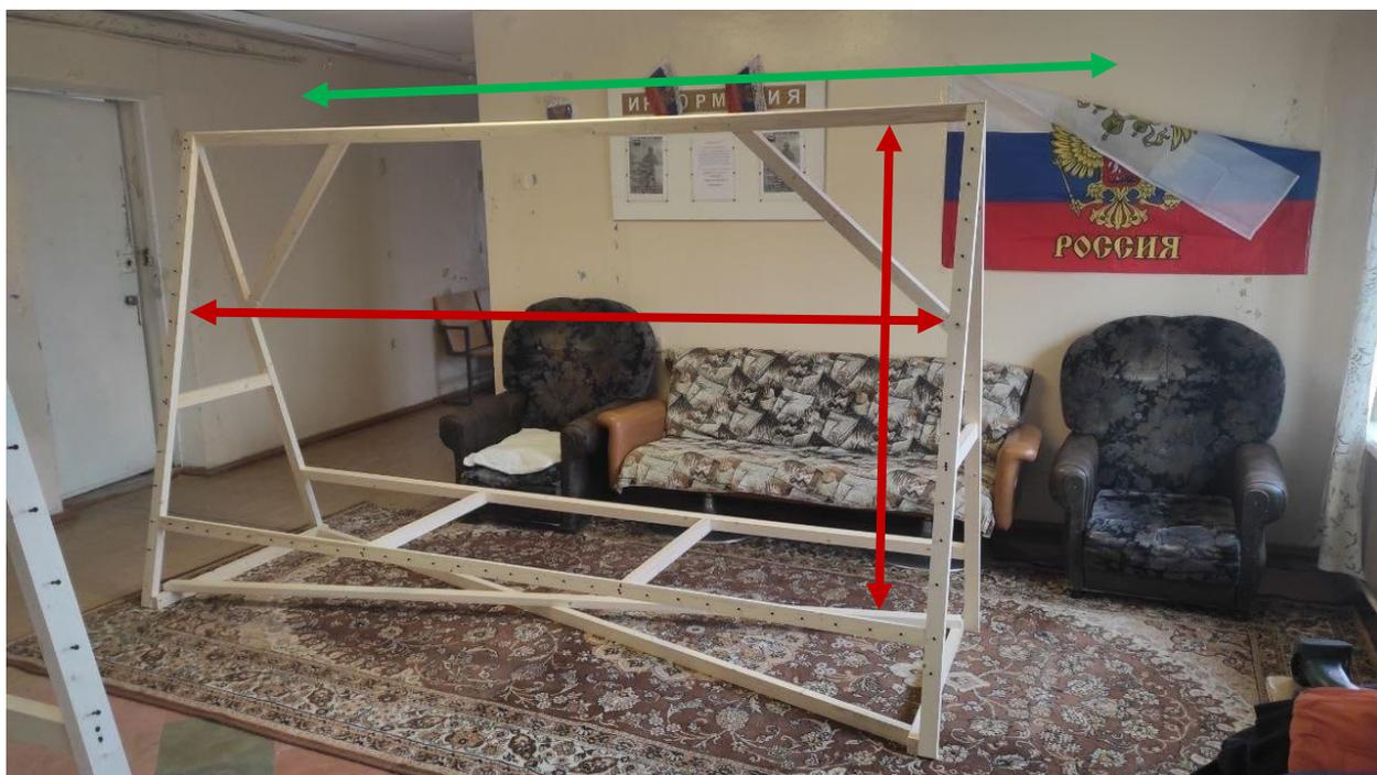
Рекомендуется усиление конструкции в верхней и нижней части для устойчивости при проведении работ.
